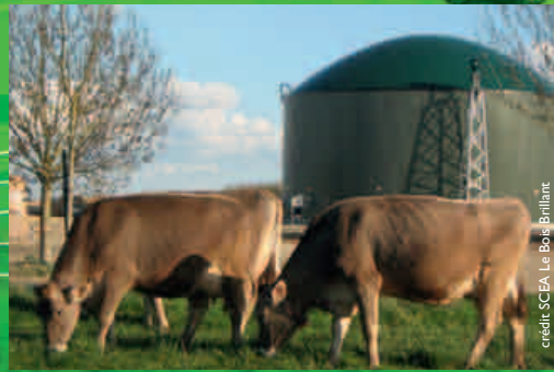
Installation biogaz, SCEA Le Bois Brillant dans le Maine-et-Loire
