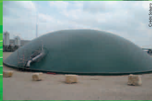
Fosse enterrée et couverte de la SAS Metha Bel Air dans la Vienne
