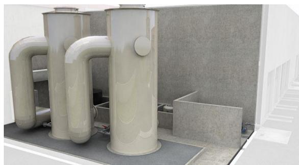
**Figure 14: Tours de lavage. La première tour permet un lavage acide neutralisant l'ammoniac et la seconde un lavage oxydo-basique (soude/javel) pour réduire les composés soufrés (H<sub>2</sub>S, mercaptans...). Source : Communauté d'agglomérations du pays ajaccien.**
