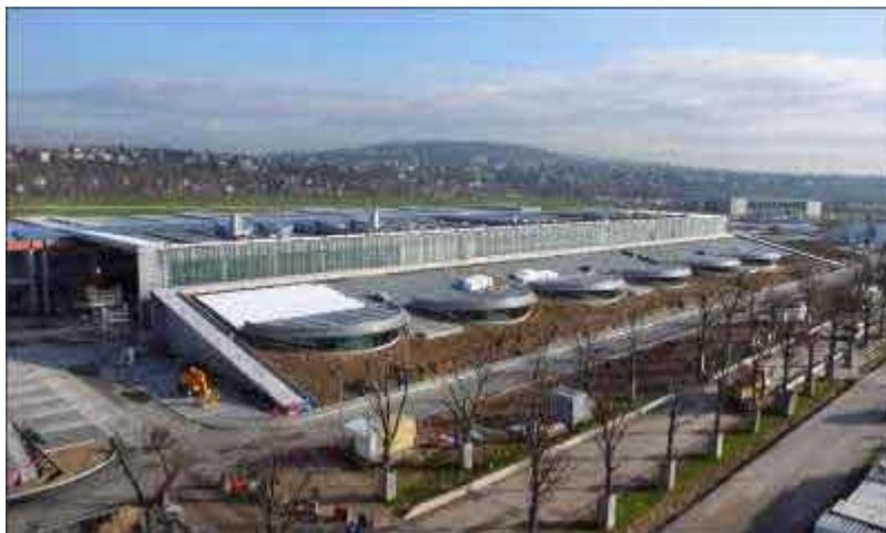
**Figure 12 :** Dans l'unité de traitement des pollutions azotées de la station d'épuration de Seine Aval (SIAAP), les flotateurs de boues sont munis de couvertures planes. Source : [www.vinci-construction.fr](http://www.vinci-construction.fr)
