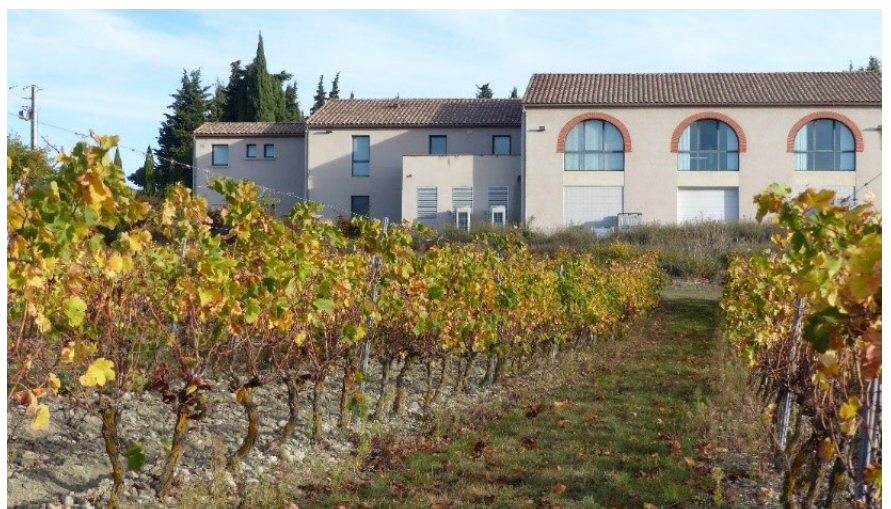
Figure 1. Vue du bâtiment principal du Domaine de Cazes
